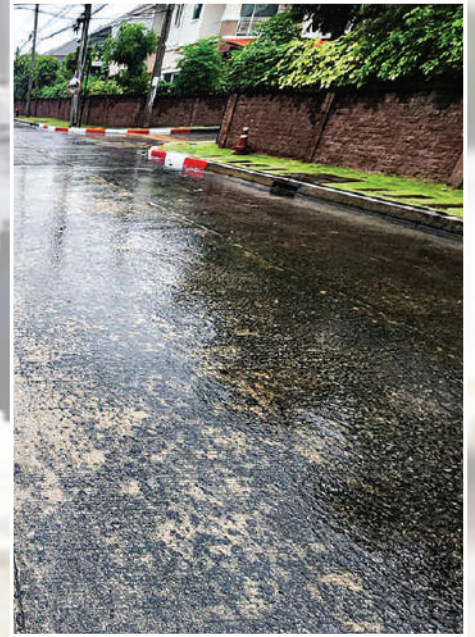
ผิวคอนกรีตที่เกิดราดำ
